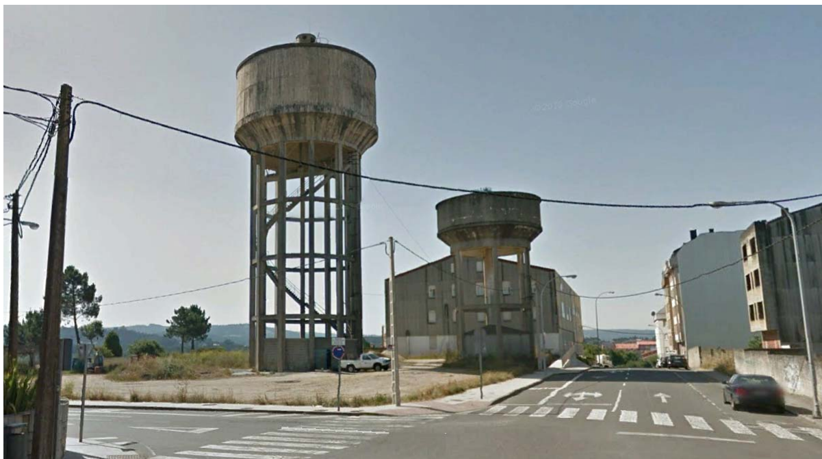
Depósitos de auga na Avenida Bergantiños.
