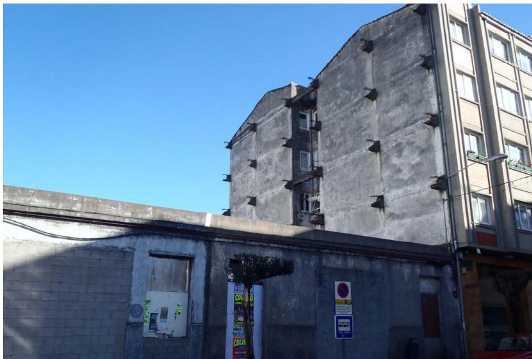
Edificio de colectiva co medianeira vista sen acabado exterior na rúa Ponte.
